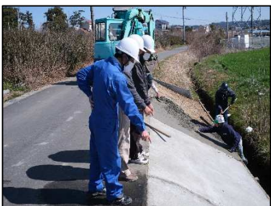
排水路法面 防草コンクリート
