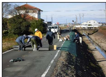
排水路法面 防草シート設置
