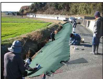
水路法面 防草シート設置
