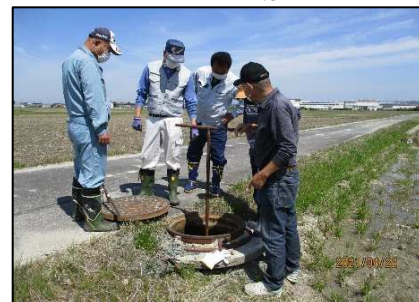
パイプライン付帯施設の 機能診断
